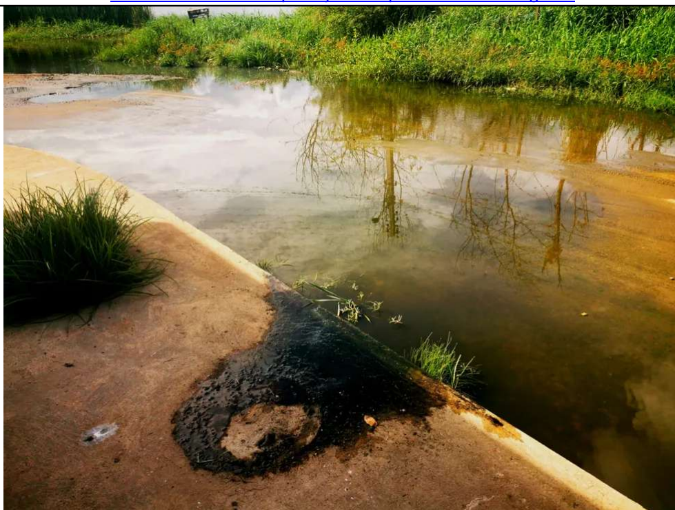
Foto 02: Transbordamento da elevatória de esgoto nas ruas do entorno da Lagoa do Mato devido às chuvas
